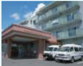
市営アパート5号館の1階部分です
