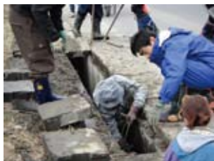
側溝の泥出し
